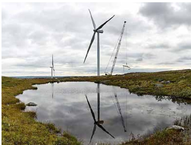
Рис. 5. Строительство Кольского ветропарка
