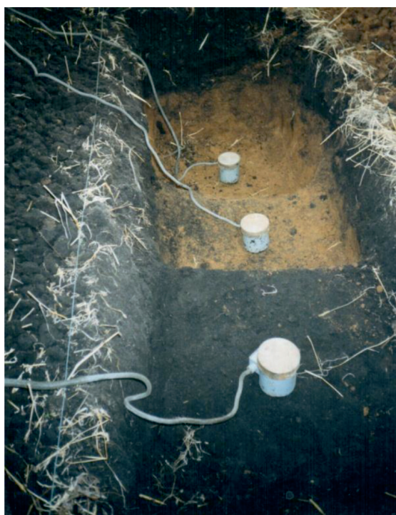
Рис. 2. Установка датчиков давления в почве
