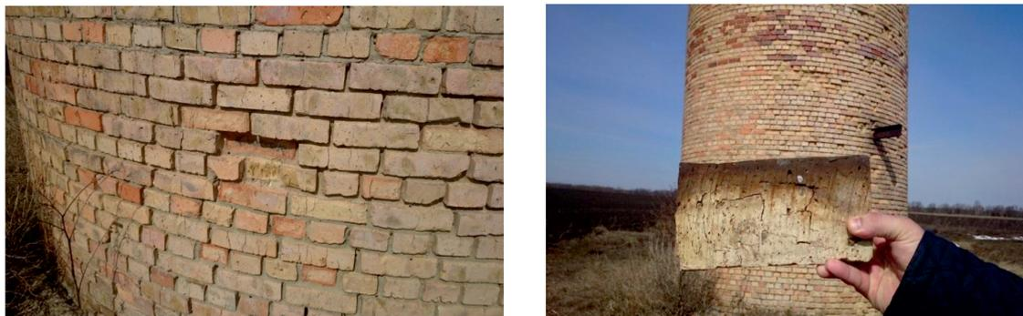
Рис. 5. Исследуемая водонапорная башня (изъятие образцов для испытаний)
