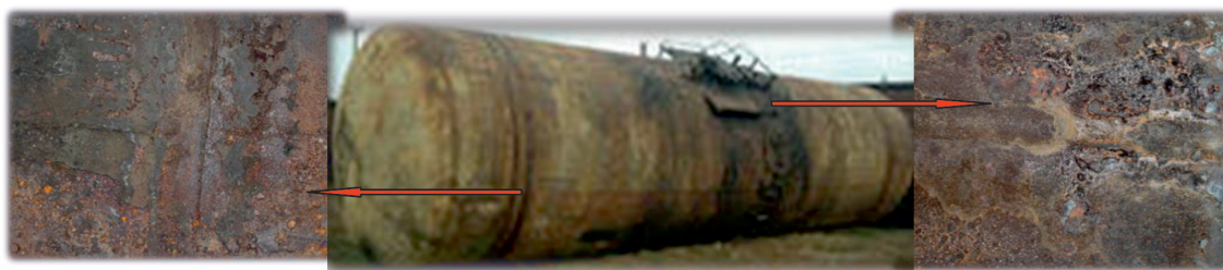
Рис. 3. Характерные повреждения материала котла цистерн для транспортировки нефтепродуктов на стадии предразрушения
