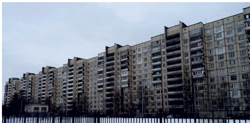
Рис. 1. Общий вид здания
