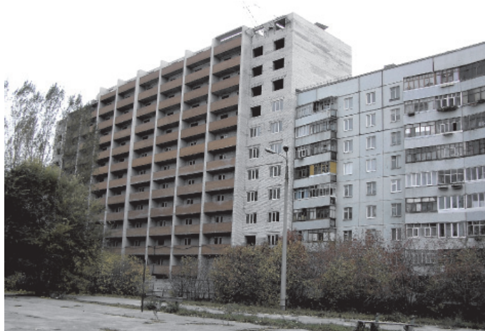
Рис. 2. Общий вид дома № 2 по фасаду
