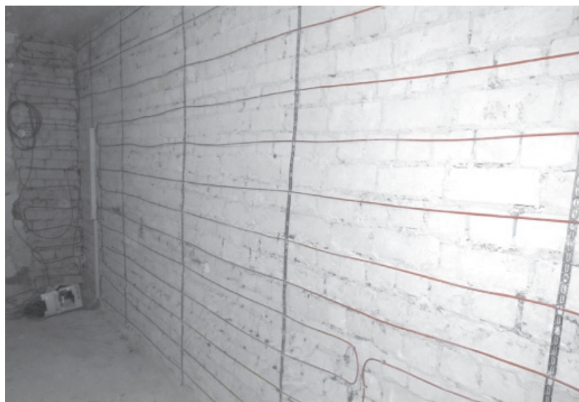
Рис. 4. Нагревательный кабель на внутренней поверхности стены
