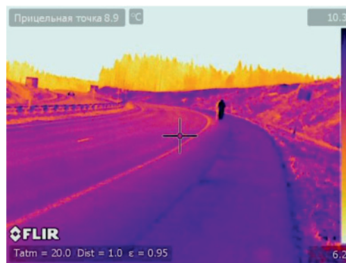
Рис. 2. Температура поверхности (участок дороги в выемке)
