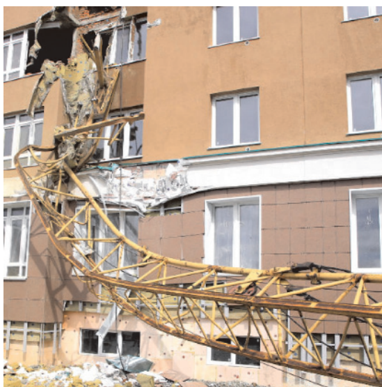
Рис. 2. Обрушение башенного крана в г. Кемерово
