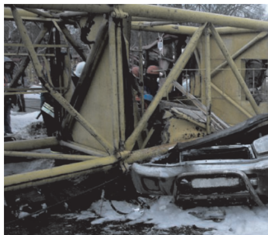
Рис. 1. Обрушение башенного крана в г. Омске
