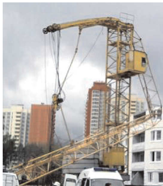
Рис. 4. Падение башенного крана в Подмосковьё
