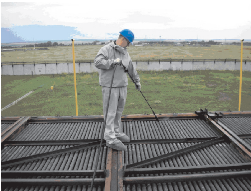
Рис. 1. Очистка наружной поверхности АВО
