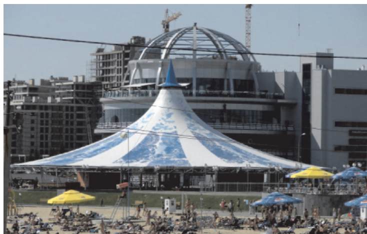
Рис. 2. Шатровое покрытие сооружения в Казани диаметром 50 м
