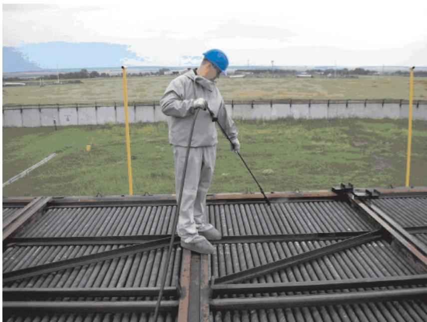
Рис. 1. Очистка наружной поверхности АВО
