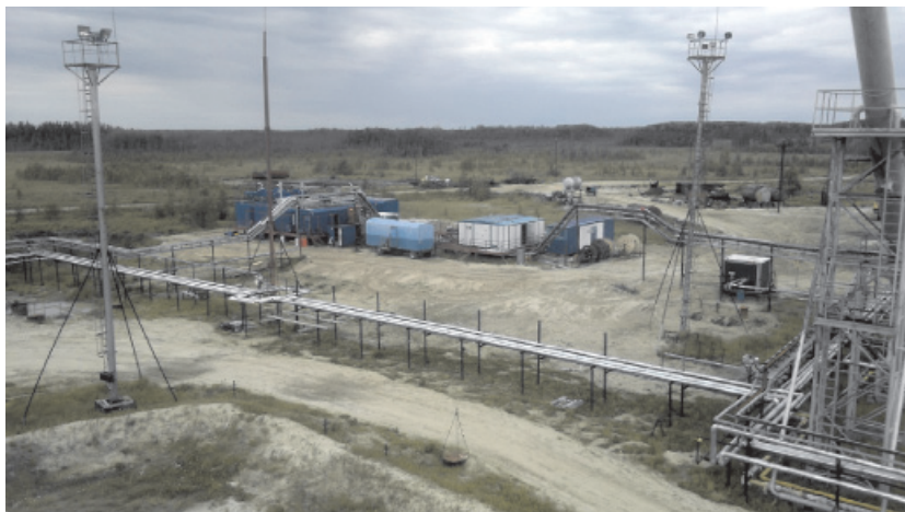
Рис. 3. Действующая газопоршневая установка на месторождении
