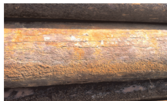
Рис. 2. Трещины коррозионной усталости элементов ОБ МСП
