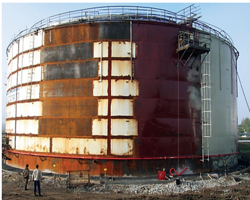
Рис. 1. Резервуар РВС-10000 во время восстановления АКП с зачищенными участками стенки в околосшовной зоне
