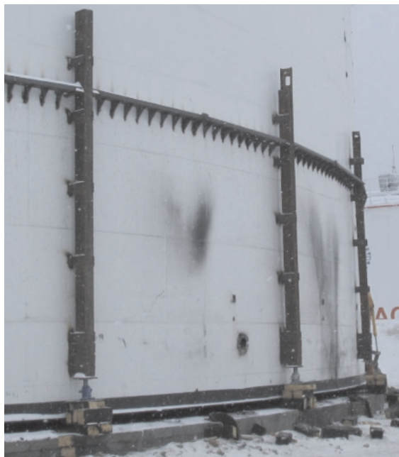
Рис. 1. РВС-20000 с усиливающими элементами на установленных гидродомкратах
