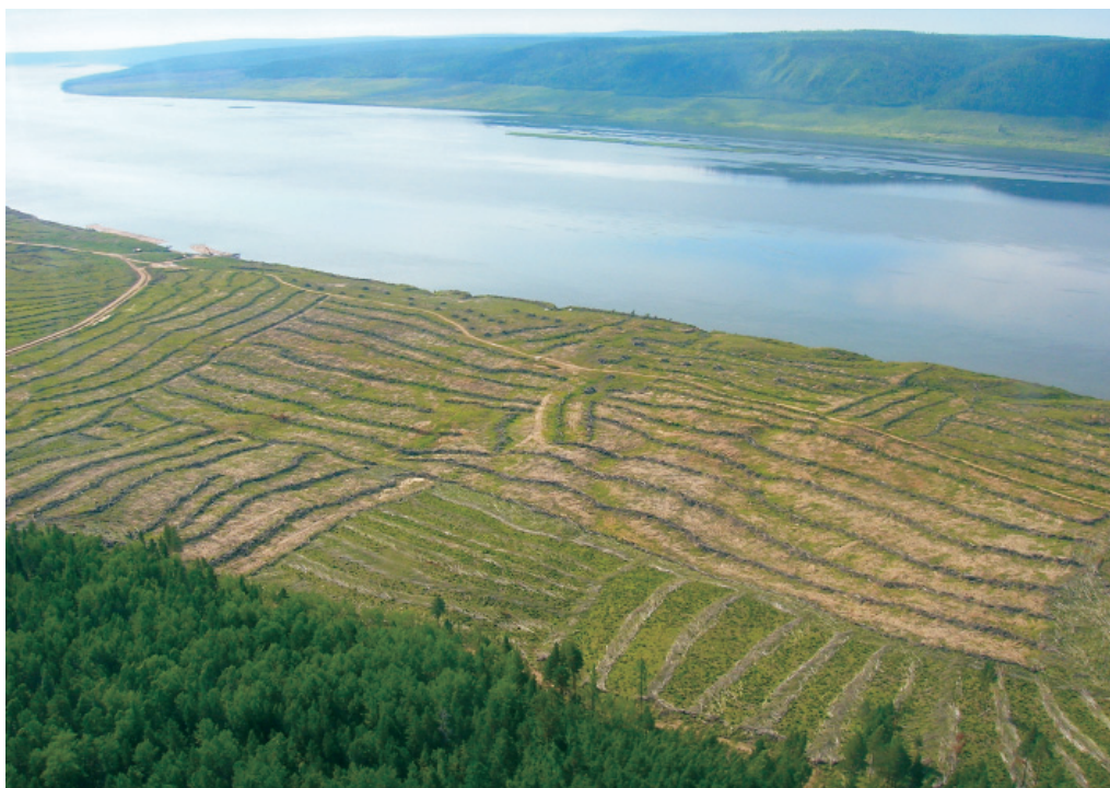
Лесоочистка участка специального назначения в ложе водохранилища Богучанской ГЭС
