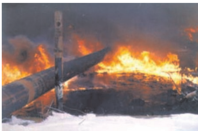
Рис. 2. Авария на трубопроводе с пожаром
