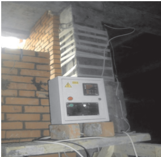
Рис. 1. Установка термоактивной опалубки для обогрева шпунтового соединения колонны и фундамента
