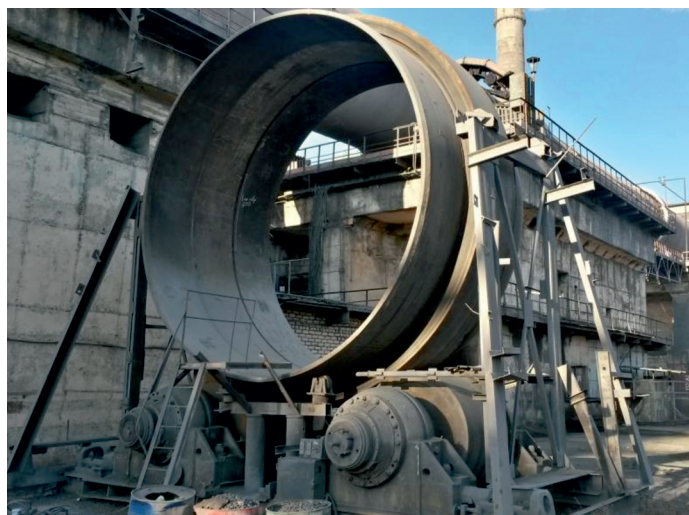
Рис. 6. Бандаж с кольцевыми обечаками на специальном стенде для их сварки
