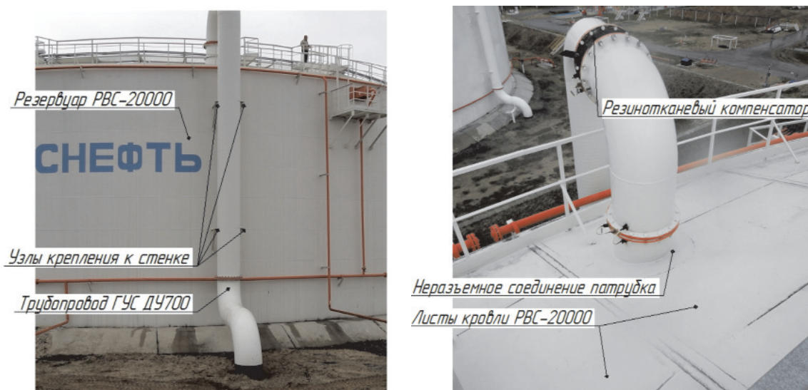
Рис. 1. Общий вид узла соединения ГУС с PVC-20000
