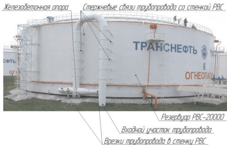
Рис. 1. Общий вид узла присоединения трубопровода аварийного сброса нефти к РВС-20000
