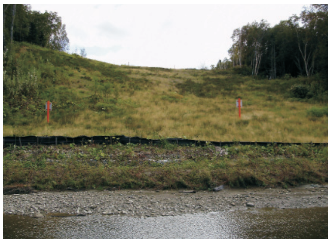
Рис. 2. Место прокладки нефтегазопровода через р. Ай
