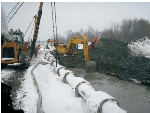
Рис. 1. Река Ай – строительство перехода нефтегазопровода, рытье траншеи, 2006 год (источник: официальный сайт «Сахалин Энерджи» [www.sakhalinenergy.com](http://www.sakhalinenergy.com))
