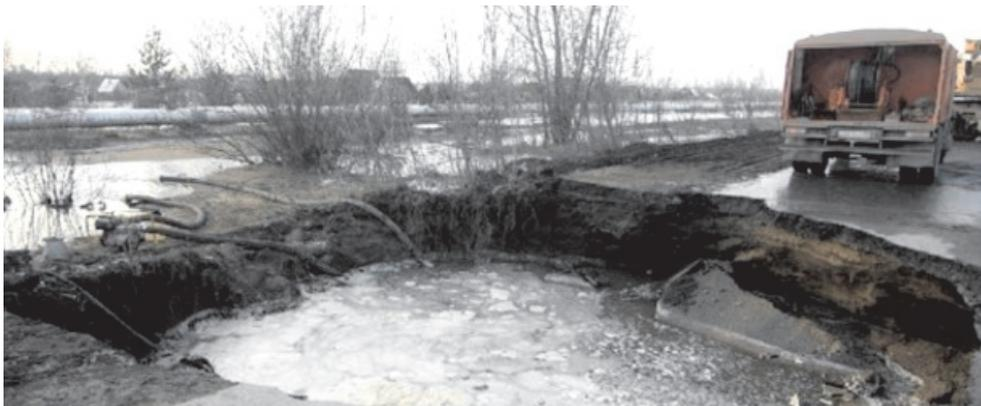
*Рис. 1. Провал асфальтовой дороги при активизации суффозионных процессов*
