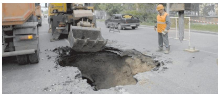
*Рис. 2. Провал асфальтовой дороги*
