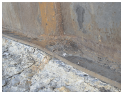
Недопустимая деформация листов металла окрайки
