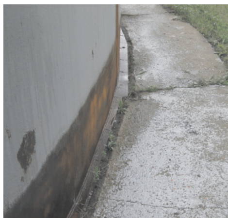
Неравномерный выступ окрайки
