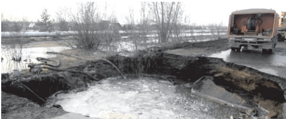
Рис. 1. Провал асфальтовой дороги при активизации суффозионных процессов
