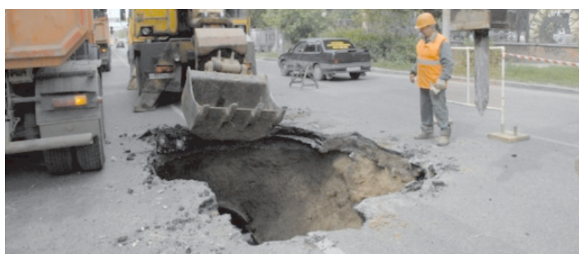
Рис. 2. Провал асфальтовой дороги
